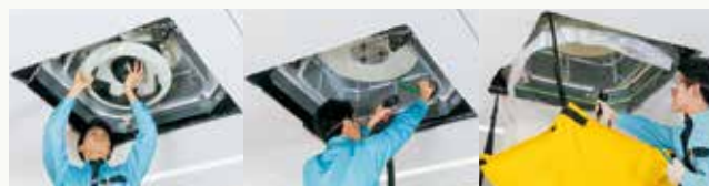
1 分解 2 ホコリの除去 3 内部クリーニング
