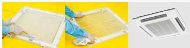
4 パーツのクリーニング 5 拭き上げ 6 仕上げ
