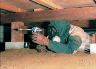
安全性に配慮したニオイの少ない薬剤を床下へ直接散布して駆除・予防するバリア工法。薬剤の効果は5年間持続します。
