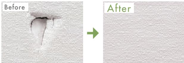
破損した石膏ボードをパテで埋め、壁紙を貼ることで
